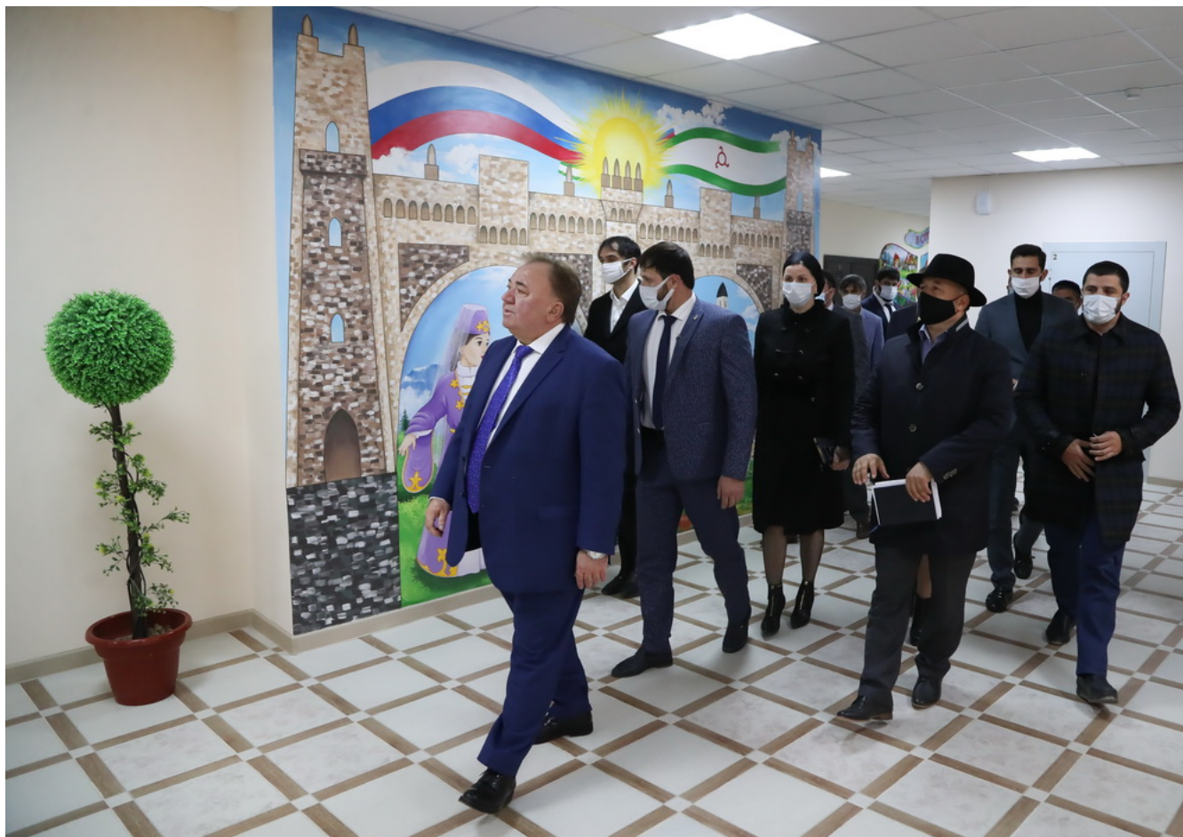
Президент РТ Махмуд-Али Калиматов с делегацией осматривает строящуюся школу и детсад в Магасе.
